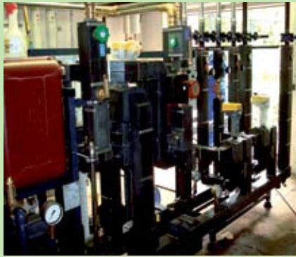
Ansicht einer im Modernisierungsumbau befindlichen Anlage
