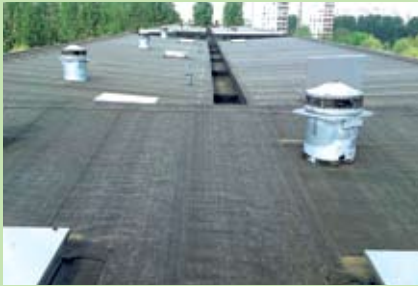
Sanierte Dächer sollen hohen Standards genügen
