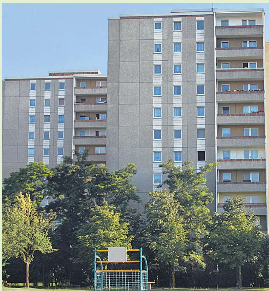
August 2009 – vor Beginn der Baumaßnahme
