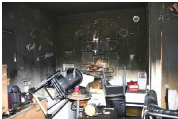
Wer solch einen Wohnungsbrand erleidet, verliert viel Ideelles. Besteht eine passende Versicherung kann man sich wenigstens trösten, finanziell nicht bei Null anfangen zu müssen. Bildquelle: Gutachten des LKA
